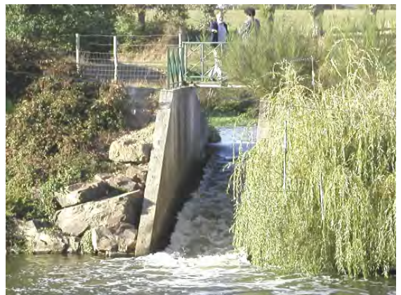
Figure 4.3.17. Pont Réan Weir eel pass
